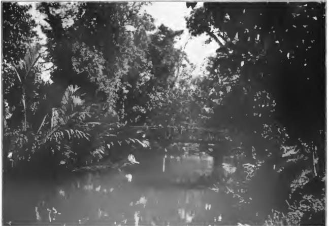
Reichs-Kolonialamt, Bildersammlung. Jombabrücke bei Friedrich-Wilhelmshafen (Kaiser-Wilhelmsland).
